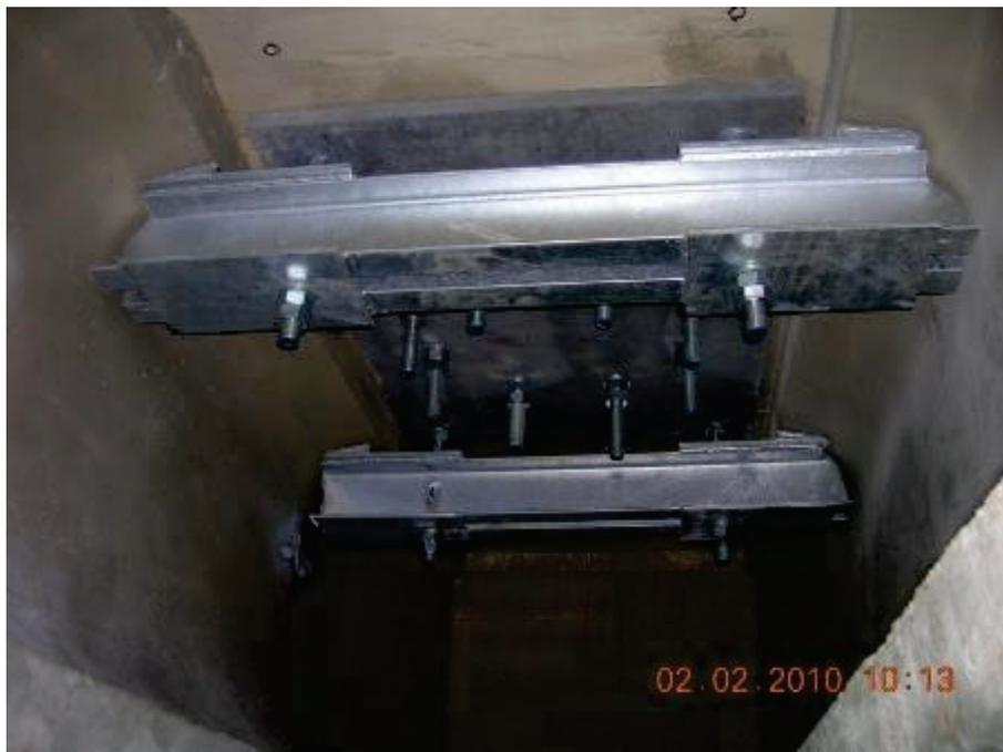
GAETA (LT) – PARTICOLARE STRUTTURA SPECIALE DI ANCORAGGIO IN ACCIAIO (INTRADOSSO BANCHINA)
